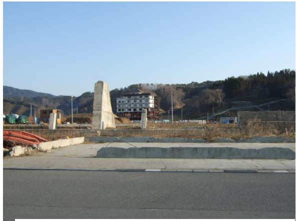
遠くに「たろう観光ホテル」を見る「震災遺構」 手前が壊れた防波堤
